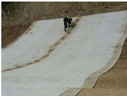
Installation of Geosynthetique Bentonitique (GCL)
